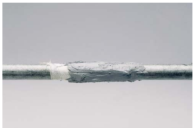
Fotografia 4 – Riparazione d'emergenza di un tubo
