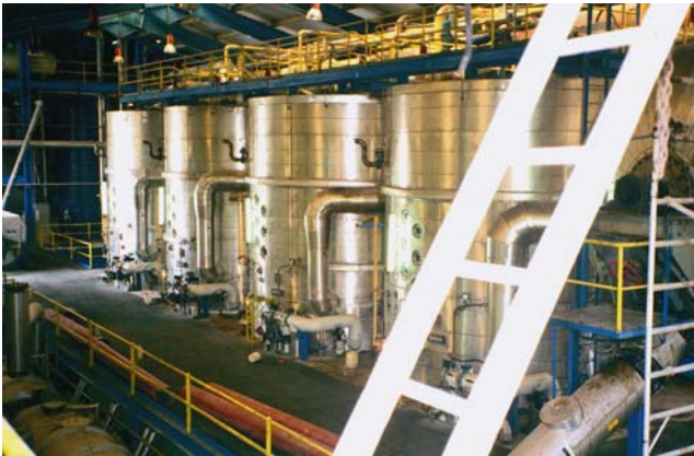
Fotografia 1 – riparazione di serbatoi in acciaio inox
